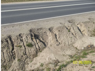
Przepusty - luźne kamienie zabruku do ponownego montażu
