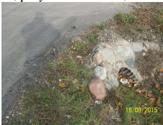
Przepusty - luźne kamienie zabruku do ponownego montażu
