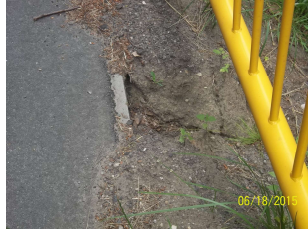
Przepusty - luźne kamienie zabruku do ponownego montażu
